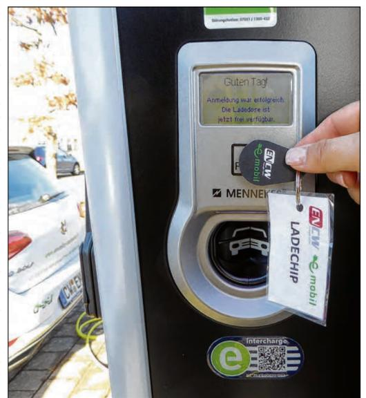
Mit einem Chip wird die Ladesäule freigeschaltet.
